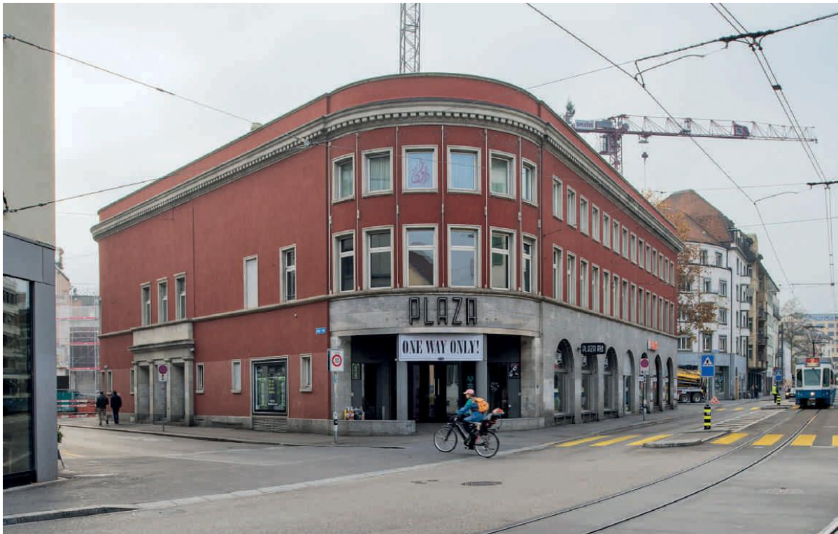
Ehemaliges Kino «Kosmos» (heute «Plaza»-Gebäude), abgerundete Gebäudeecken und eng stehende Fensterreihen wie ein abrollender Filmstreifen, 2018. Foto Juliet Haller, BAZ
