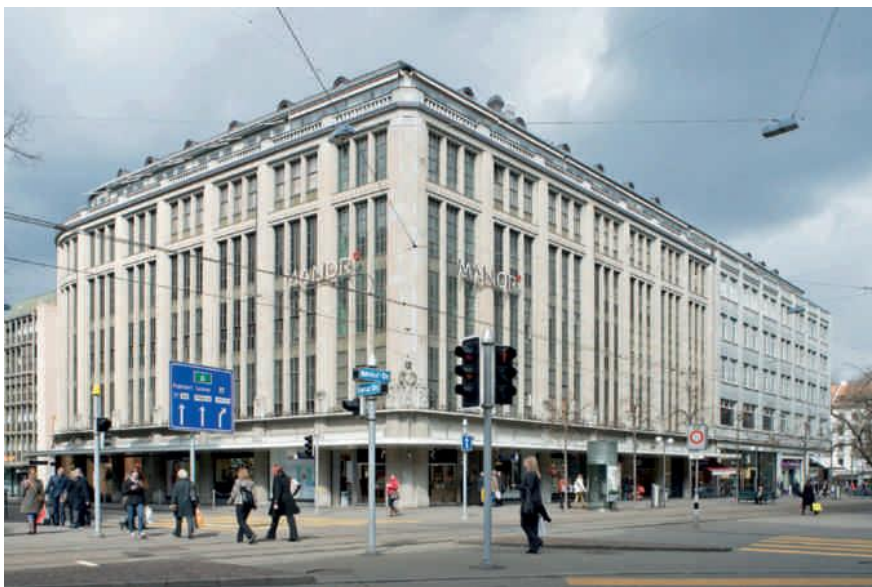
Warenhaus Brann (heute Manor) an der Bahnhofstrasse, Sakralisierung der Warenwelt mittels gotisch aufstrebender Pfeilerarchitektur, 2013. Foto Juliet Haller, BAZ
