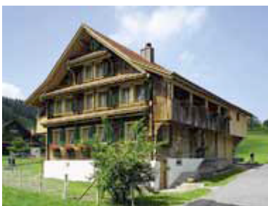
Abb. 1 Haus Unterblacki nach dem Umbau, Ansicht von Nordosten: Dank einem umsichtigen Umbaukonzept konnte die ursprüngliche Grundrissstruktur und viel von der originalen Bausubstanz
