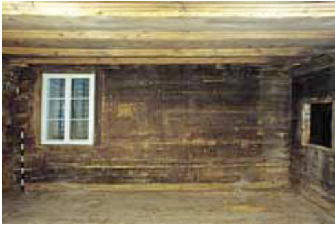
Abb. 4 Haus Unterblacki, Blick in die Stube mit repräsentativer Bohlen-Bälkchen-Decke: An der Wand sind vertikale Schmutznegative des Brettertäfers aus dem frühen 17. Jahrhundert und das ältere, horizontale Standnegativ der Eckbank sichtbar. Auf der Blockwand klebt der Einblattdruck mit der Darstellung der «Sieben Schmerzen Mariens»
