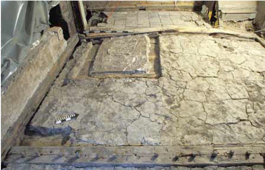
Abb. 11 Haus St.-Oswalds-Gasse 10, erstes Obergeschoss, Raum 10: Auf dem originalen Lehm Mörtelstrich, in dem das Negativ des Ofenfundaments noch sichtbar ist, lagerten zahlreiche Funde
