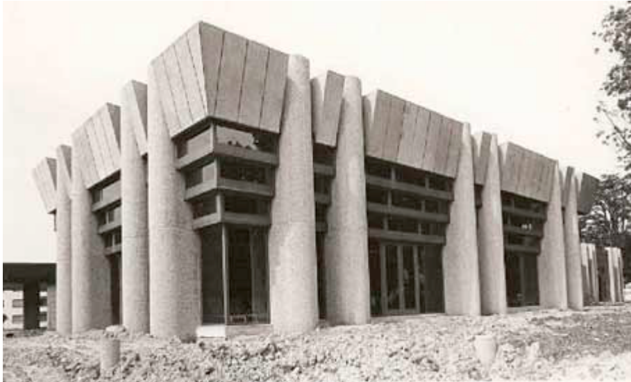
1977 Le Centre thermal construit selon les plans de l'architecte François Cattin et inauguré le 10 septembre 1977 à l'occasion de la renaissance des activités thermales à Yverdon-les-Bains après une interruption de dix-huit ans. (Photo Alain Martin, 1977)
