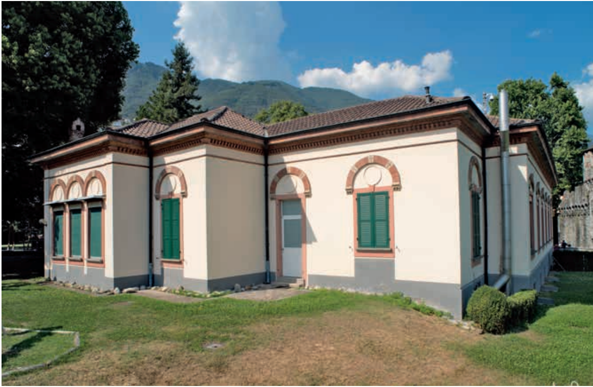
Asilo infantile di Locarno (1887) progettato da Augusto Guidini sr. Veduta da sud e particolare del medaglione raffigurante Dante. Foto Claudio Berger
