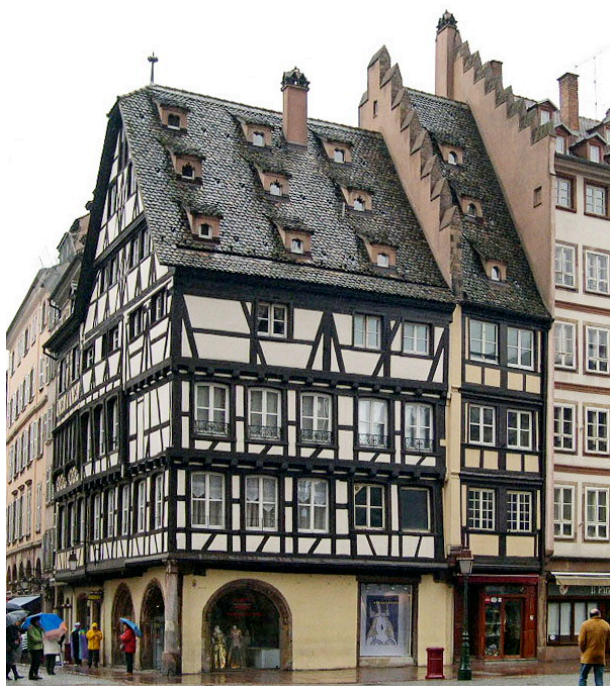
Figure 7 : Photo des maisons formant l'angle de la rue du Dôme et de la place de la cathédrale. Le bâtiment à gauche, ancienne pharmacie du Cerf, est très composite, avec un rez de chaussée voûté édifié en 1497 et des étages datés des XVe-XVIIIe s. dont une partie reconstruite après l'incendie de 1466. Le bâtiment à droite, très étroit et entre deux pignons maçonneries saillants, a été construit en 1300, après le grand incendie de 1298.
