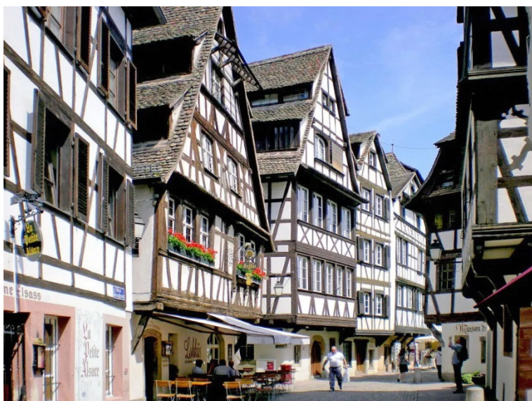
Figure 12 : Vue d'une série d'encorbellements simples conservés actuellement, rue du Bain-aux-Plantes (doc. Hugo Clément).
