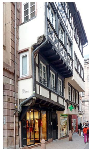
Figure 13: Vue d'un encorbellement double, rue des Orfèvres (doc. Hugo Clément).
